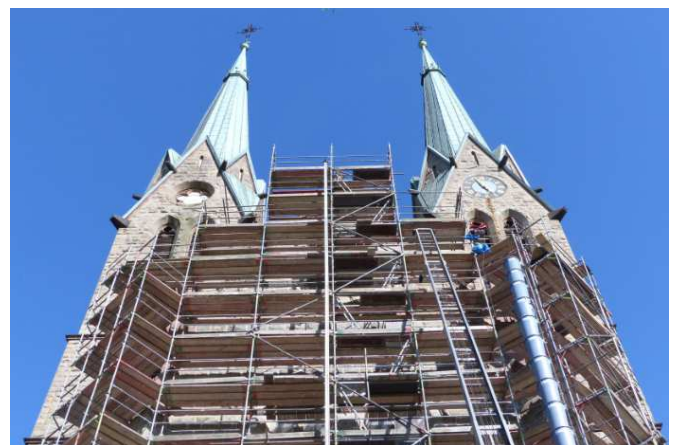
Baustelle Kirche, Foto: ThE
